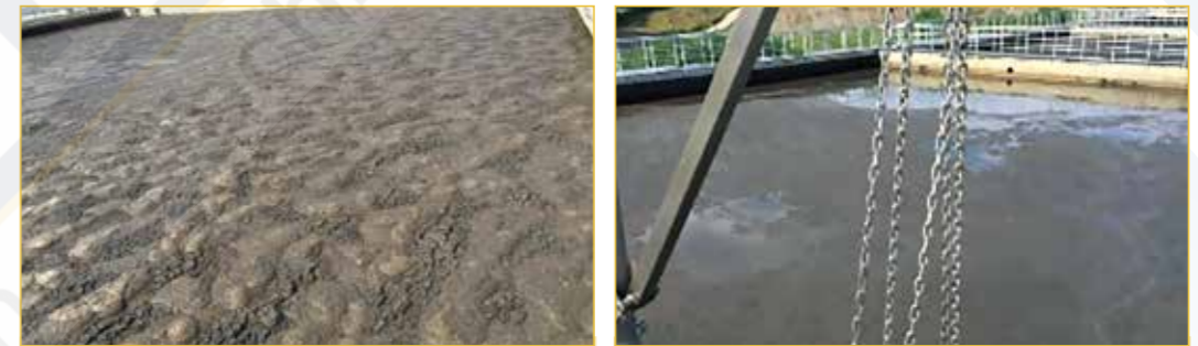
缺氧池更换碳源前后对照图（左为跟换碳源前，右为更换碳源后）
