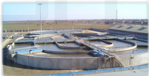
氧化沟全液内回流及一体化结构
